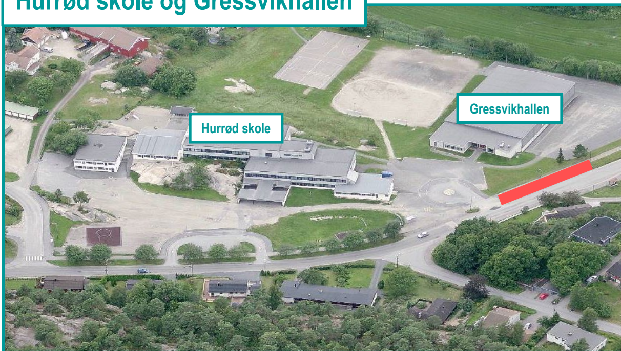
Hurrød skole og Gressvikhallen
